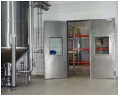
Feuerschutztür, marmorierte Oberfläche, in einem Brauereibetrieb.
