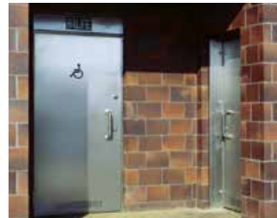
Öffentliche WC-Anlage auf einem Rastplatz.
